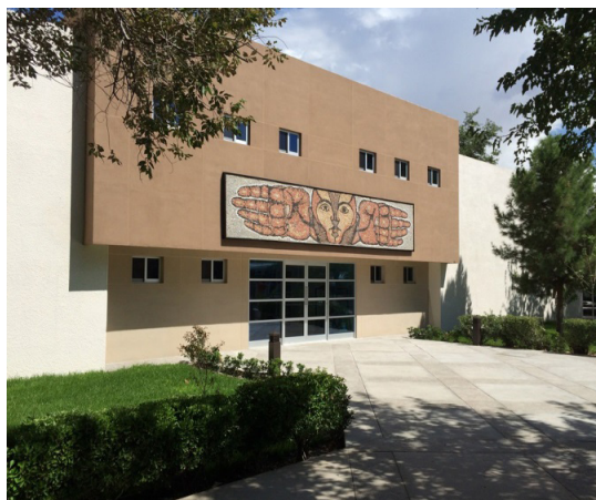
Edificio A del IADA.
